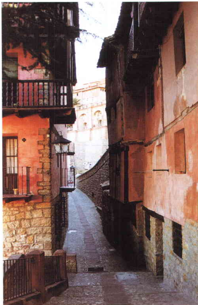
El pavimento de las calles esconde debajo una red de cableado subterráneo que ha hecho desaparecer los cables de las fachadas.
